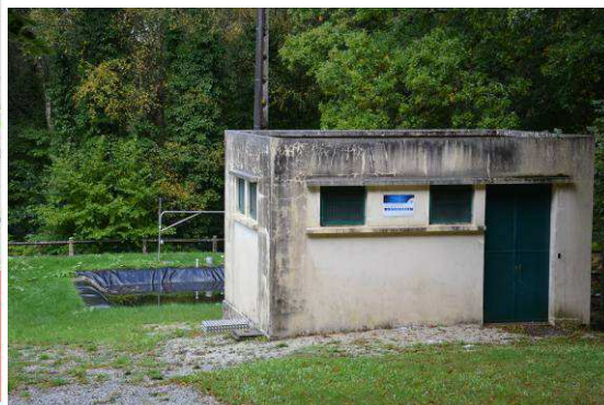
captage d'eau de Rosquelfen
