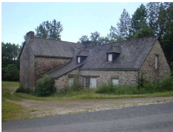
Maison du site
